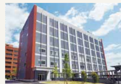
「基礎3号館」の新築
