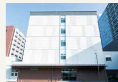
病院北館(総合複合棟・放射線腫瘍センター)の新築
